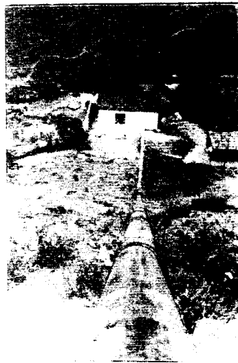
9) TUBULAÇÃO FORÇADA e CASA DE FORÇA - Vistos Montante
