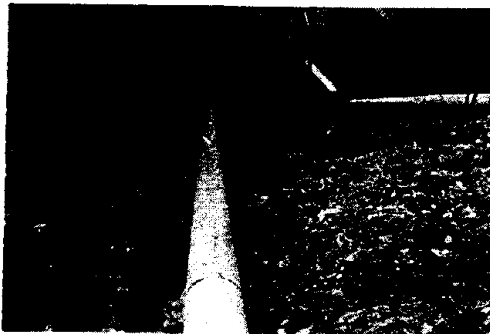
h) TUBULAÇÃO FORÇADA-Vista de Montante
